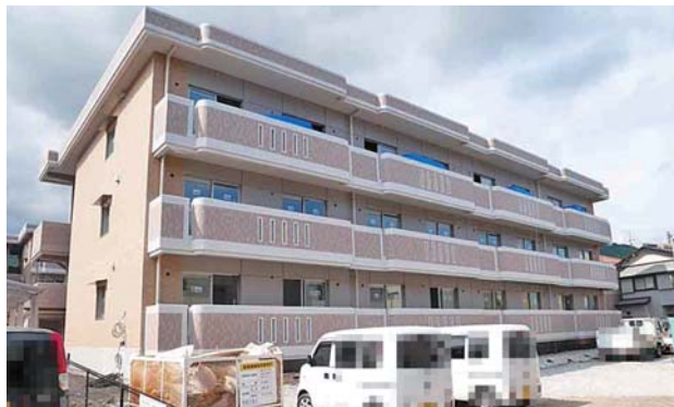
※建築中の写真です。
